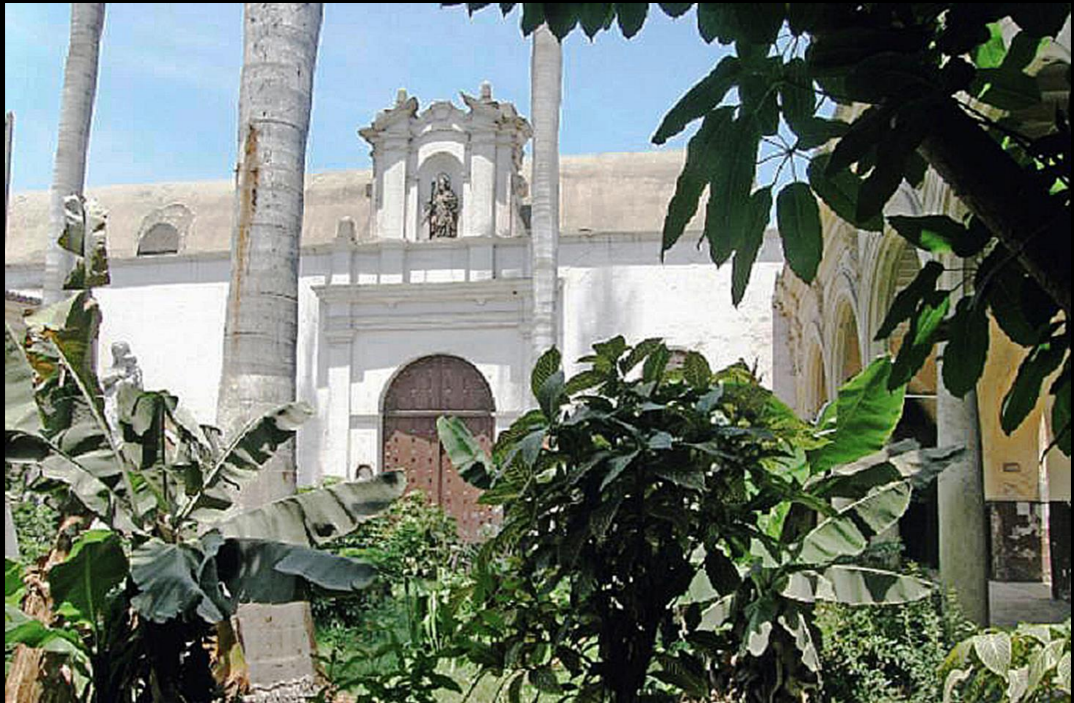
Detalle del Claustro (c. 1995) Principal del RHSA: Fachada de la Capilla
