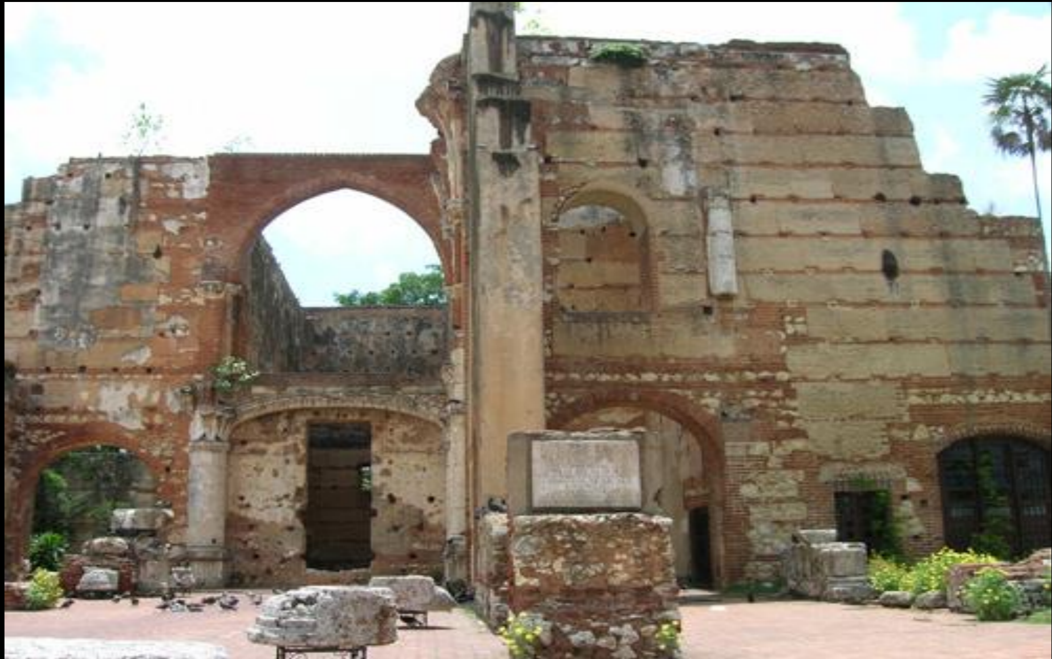
Ruinas del Hospital de San Nicolás de Bari - 1503 (Santo Domingo, República Dominicana)
